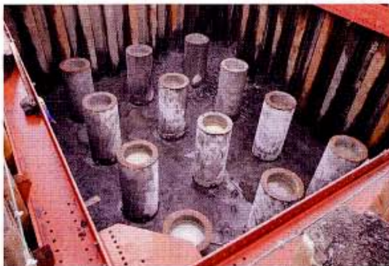
施工後の杭頭部掘削状況
